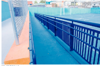
BENEFITÓRIAS. Melhorias em quadras, cozinhas, refeitórios e salas de aula estão entre as reformas
