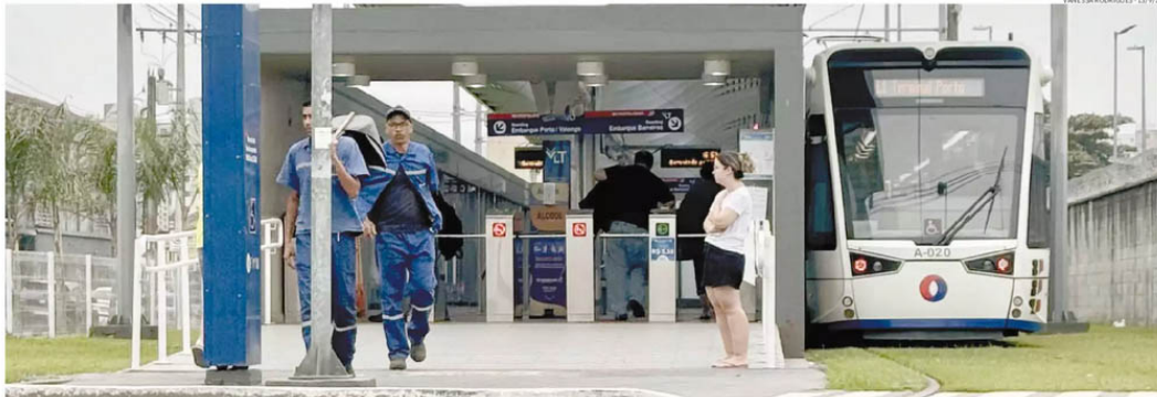
Trecho do Veículo Leve sobre Trilhos (VLT) já em funcionamento: na 2ª etapa de obras, serão construídas quatro novas estações de embarque e descida – Ponte Nova, Quarentenário, Rio Branco e Terminal Samaritá
