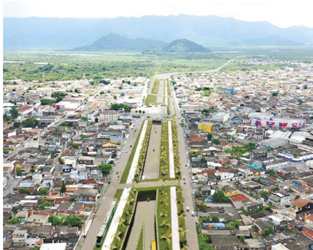
Dos 105 mil metros quadrados de mata que serão removidos, 44 mil metros quadrados são mangues, que serão desmatados e aterrados
