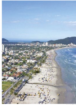
Sete em cada dez são de construtoras da Região
