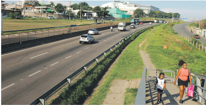
A Rodovia Santos Dumont (SP-075) desempenha um papel crucial na infraestrutura viária da região, conectando as rodovias dos Bandeirantes (SP-348) e Anhanguera (SP-330), além de proporcionar acesso ao Aeroporto Internacional de Viracopos e à Avenida Prestes Maia, uma das principais entradas de Campinas.
