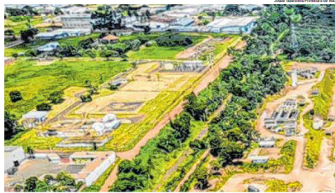
Conclusão da ETE Vargem Limpa é a principal obrigação da futura concessionária
