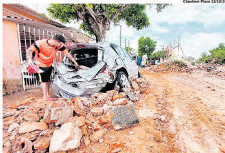
DESTRUIÇÃO. O muro da antiga fábrica da Matarazzo caiu por volta das 19h30 de sexta-feira (11) no bairro Cerâmica, em São Caetano, e atingiu um carro que estava estacionado na via. Dono, o bancário Ângelo Ernesto Júnior, 26 anos, estava com o veículo havia apenas três semanas e afirmou que não houve feridos, apenas danos materiais. O Grande ABC e as demais cidades da Região Metropolitana de São Paulo foram atingidos por temporal que provocou apagão, que se prolongou até a sexta-feira (18).
