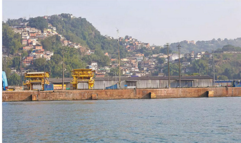
Definição do STS10, no cais do Saboó, ocorre após muito suspense; área atualmente tem apenas o terminal Ecoporto, cujo arrendamento já venceu e foi prorrogado até dezembro
