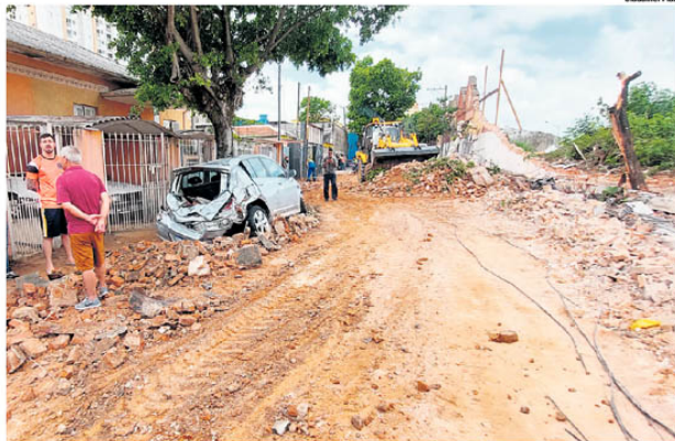
ESTRAGOS. Muro da antiga fábrica da Matarazzo caiu em São Caetano e danificou veículo na rua
