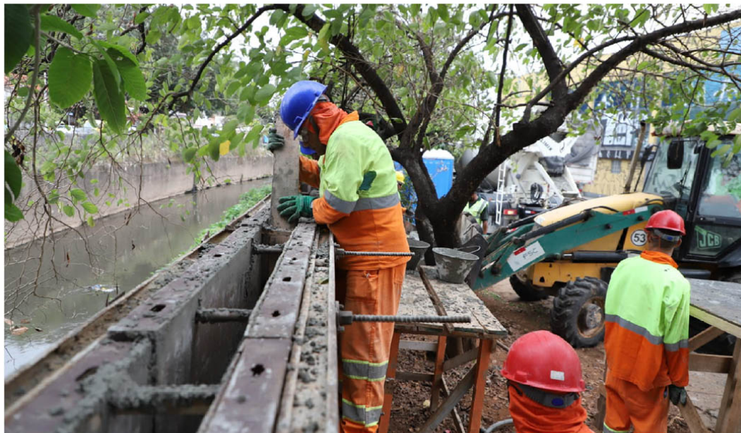
O ReFundação, maior programa de combate a enchentes de São Caetano, faz parte do PRODESA - Programa de Desenvolvimento Ambiental e Saneamento Básico de São Caetano do Sul, que teve início em março de 2024, com previsão de conclusão para 2026
