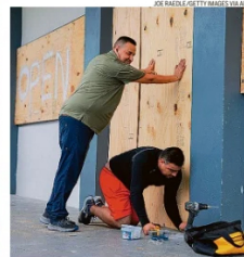
Precaução. Reforçando portas e janelas em Fort Myers
