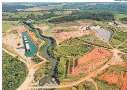
Menos da metade das obras da barragem de Amparo foi concluída; expectativa é que, juntas, as duas barragens formem reservatórios com capacidade de armazenamento útil de 85 bilhões de litros de água
