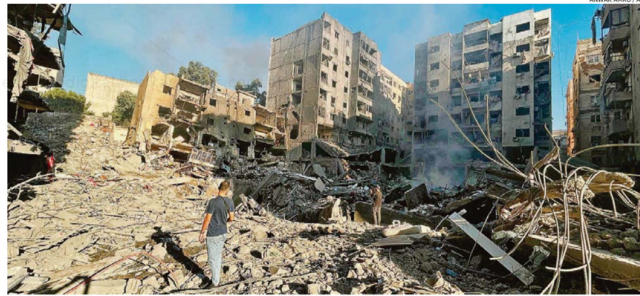
Bombardeios de Israel em subúrbio próximo a Beirute destruíram edifícios residenciais; 30 pessoas morreram ontem, disseram autoridades
