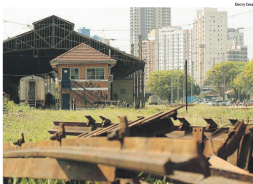
Complexo ferroviário abrigou no passado as instalações da Companhia Paulista de Estradas de Ferro, oficinas da Companhia Mogiana de Estradas de Ferro e, posteriormente, da Fepasa
