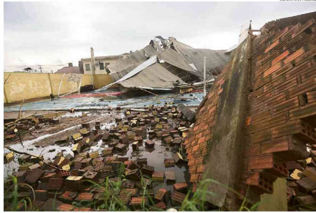
Camaquã, na Região Sul, decretou situação de emergência após temporal danificar centenas de imóveis
