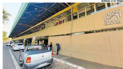
Emdurb fica no Terminal Rodoviário de Bauru
