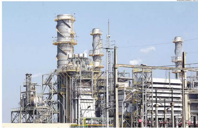
Termelétrica de Cubatão: apesar da seca, com impacto nos reservatórios, ministro descarta acionar usinas térmicas, que pesam nas tarifas
