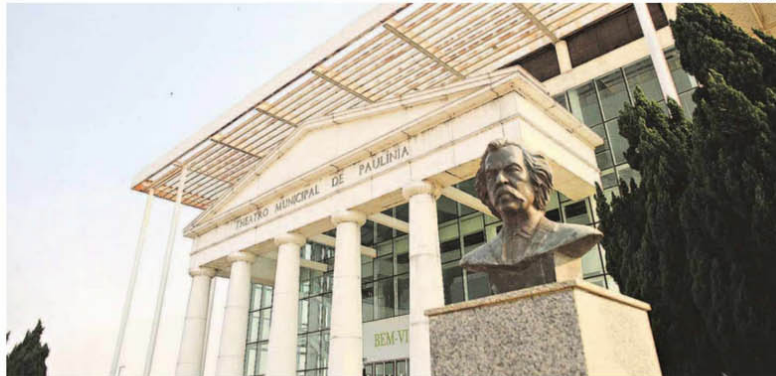
O Teatro Municipal de Paulínia, outrora reconhecido como um dos mais bem equipados do país, necessita de uma reforma completa, pois todo o seu interior, feito de madeira, está infestado por cupins; o custo estimado para a restauração varia entre R$ 4 e R$ 5 milhões
