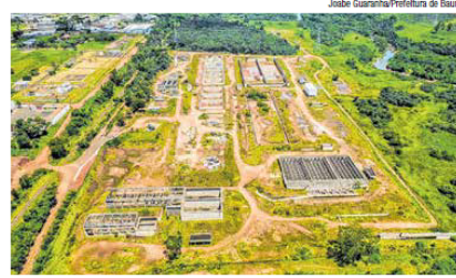
Estação de Tratamento de Esgoto (ETE) Vargem Limpa
