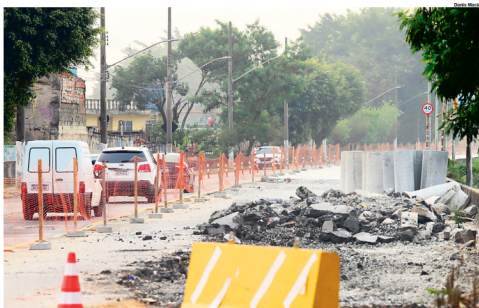
O prazo para entrega do BRT-ABC (sistema de ônibus de alta velocidade, na sigla em inglês) parece cada vez mais distante para as pessoas que aguardam o encerramento das obras na região. A princípio, o modal seria entregue em 2022, mas agora está previsto para dezembro do ano que vem. De acordo com relatos colhidos pela reportagem do Diário, a demora tem prejudicado o trânsito nos centros urbanos e, consequentemente, a rotina de moradores e empresas que estão na região. As intervenções são gerenciadas pela EMTU (Empresa Metropolitana de Transportes Urbanos) e realizadas pela concessionária Next Mobilidade. O começo das operações será em 2026 – inicialmente, a capacidade ficará em torno de 173 mil passageiros por dia. O projeto, cujo custo chega a R$ 920 milhões, engloba 92 ônibus elétricos da empresa Eletra, 16 paradas e 18 quilômetros de extensão. Setecidades 4
