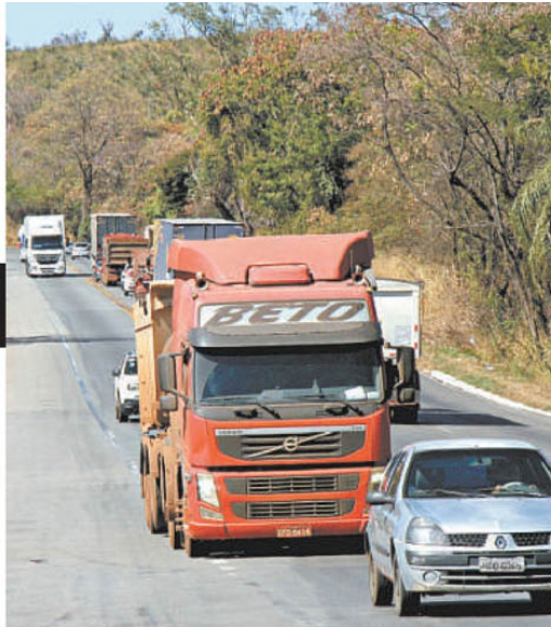
TRÁFEGO NO KM 30 DA BR-381, UM DOS TRENCHOS RODOVIÁRIOS QUE PERDERAM RADARES NOS ÚLTIMOS TRÊS ANOS E QUE CONTINUAM SEM O EQUIPAMENTO DE FISCALIZAÇÃO ELETRÔNICA
