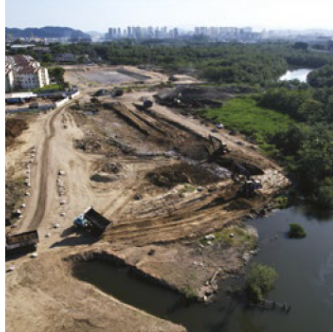
Obra de Macrodrainagem do Rio Santo Amaro
