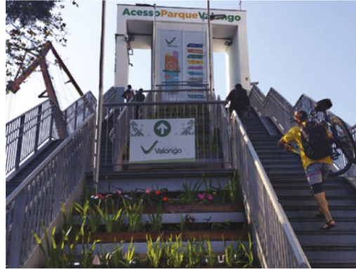
A rampa foi prometida pela APS e já deveria estar sendo usada, pois havia sido aprovada no ano passado
