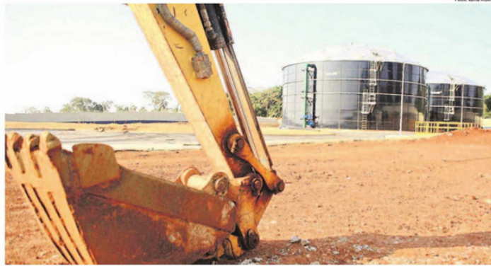
No Parque das Universidades, em Campinas, estão sendo construídos reservatórios capazes de armazenar seis milhões de litros de água; esses projetos, financiados pela Sanasa, resultaram na criação de pelo menos 50 mil empregos diretos, indiretos e induzidos
