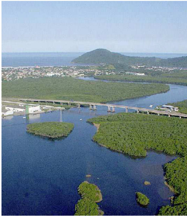
Reforma da ponte sobre o Rio Itapanhá, em Bertioiga, será o 'pontapé' inicial de parceria entre o Estado e o Consórcio Novo Litoral
