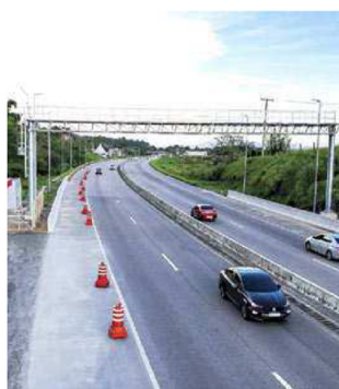
Pedágio free flow Pórtico localizado na Rodovia Rio-Santos
