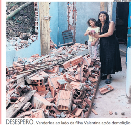
DESPESERO. Vandereia no lado da filha Valentina após demolição
