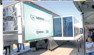
Estrutura é composta por carretas e ônibus e foi montada no Trecho 2 da cidade
