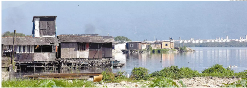
A maior parte do dinheiro será utilizada para a reurbanização do bairro São Manoel, na Zona Noroeste, e também para o projeto do Parque Palafitas, no Bom Retiro, que deve retirar famílias de moradias de risco
