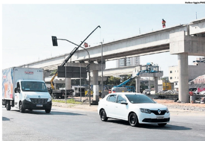
IÇAMENTO. Colocação das vigas que vão compor o viaduto requer a paralisação do trânsito no local
