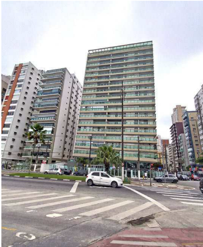
Prédio torto de Santos: solo de argila praiana e incapacidade das construtoras à época de aprofundar fundações até a 1ª camada de rochas
