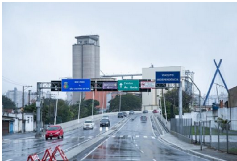
Novo Viaduto Independência
