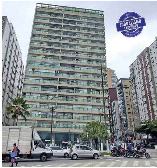
Prédio torto de Santos: solo de argila pralina e incapacidade das construtoras à época de aprofundar fundações até a 1ª camada de rochas
