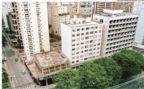
Prédio comercial sendo demolido no Itaim Bibi para dar lugar a um novo edifício residencial de luxo
