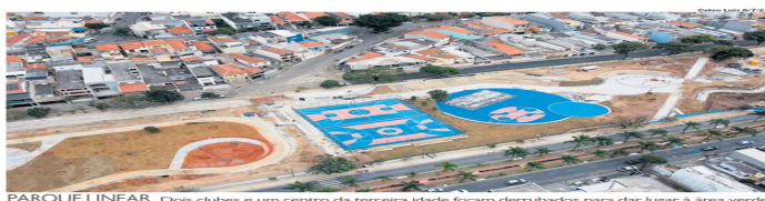
PARQUE LINEAR. Dois clubes e um centro da terceira idade foram derrubados para dar lugar à área verde
