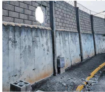
Morador relata que, recentemente, pneu de caminhão estourou e abriu buraco no muro do Residencial Samambaia; por sorte ninguém se feriu
