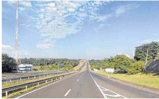
SP-225 no trecho entre Bauru e Piratininga, nas proximidades da sede da Cart
