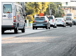
FRESAGEM. Asfalto começou a ser raspado para receber nova malha
