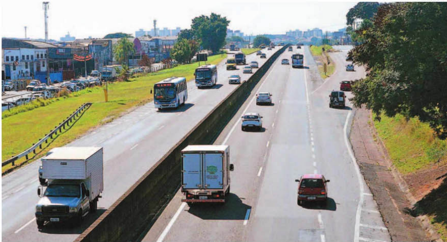
Construção de marginais em trecho da Santos Dumont pretende diminuir consideravelmente o trânsito na região, principalmente no entorno do Aeroporto de Viracopos, São José e Parque Ozêl; moradores de outras cidades, como Indaiatuba, também sofrem com os constantes congestionamentos na chegada a Campinas
