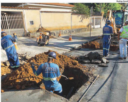
Sanasa atingiu ontem a marca de 430 quilômetros de redes de água trocadas na cidade desde 2021, quando foi lançado o Plano Campinas 2030, de segurança hídrica: redução de vazamentos
