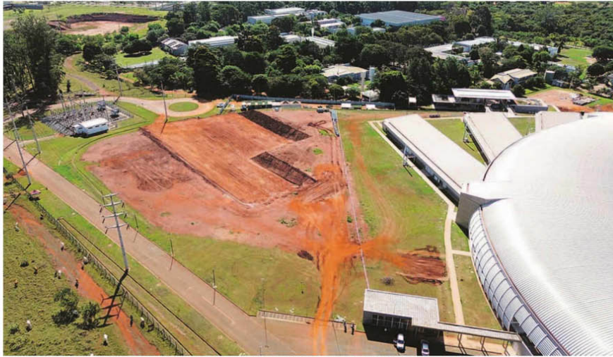
Parte civil da obra está na fase de escavação para a construção do laboratório de 20 mil metros quadrados; Orion será o único no mundo conectado a uma fonte de luz síncrotron e pesquisará micro-organismos muito perigosos, além de abrir a possibilidade de criar novos medicamentos e entender o funcionamento dos existentes para melhorar a efetividade
