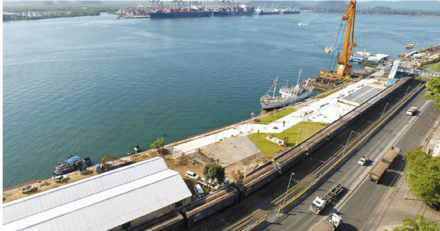
O Parque Valongo ficará na área dos antigos armazéns 4, 5 e 6. As obras da primeira fase iniciaram em setembro do ano passado para a construção de praça, playground e pier
