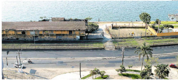
Revitalização dos antigos armazéns do Valongo ganhou impulso neste ano, com acordos que permitiram repasse da área à Prefeitura de Santos
