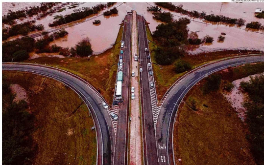
Drama gaúcho. Parte da rodovia BR-448 submerse em Caruaru, uma das cidades mais atingidas pelas fortes chuvas no RS: estrutura de seguros ainda é frágil
