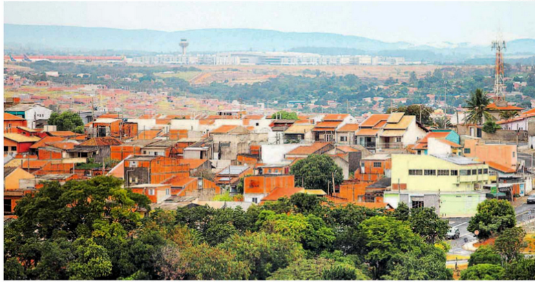
Serviço com destino a Viracopos seguirá pela Avenida Lix da Cunha, pela linha desativada da antiga Companhia Mogiana de Estrada de Ferro e passará pelos distritos de Campo Grande (foto) e Ouro Verde; ao fundo, é possível ver a Torre de Controle do Aeroporto
