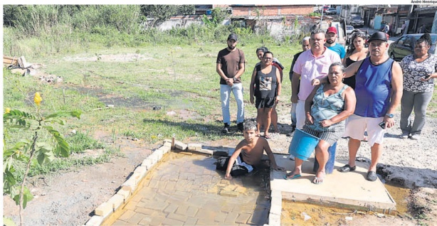
DIFICULDADE. Moradores do Capelinha aguardam por finalização da obra de novo poço; medida traria fim da falta de água e do racionamento
