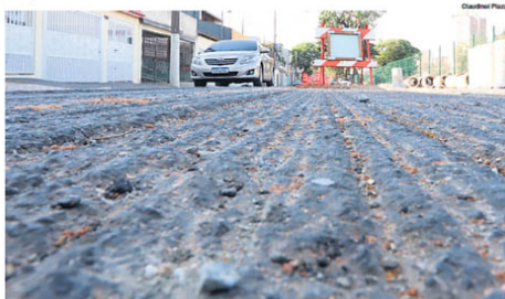
FRESAGEM. Rua Pellegrino Bernardo tem obra asfáltica iniciada e pouca sinalização aos motoristas
