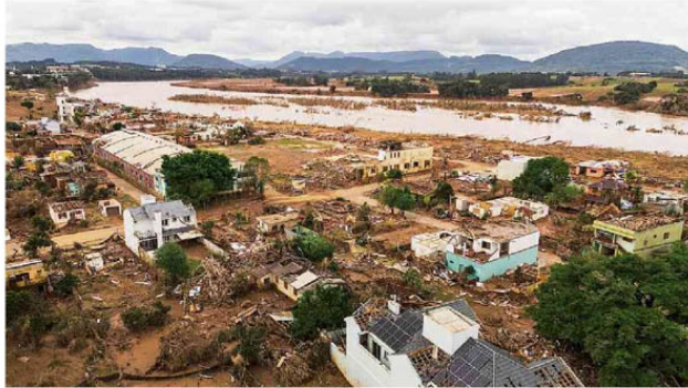
Enchente comprometeu a infraestrutura de diversas localidades, como Arroio do Meio
