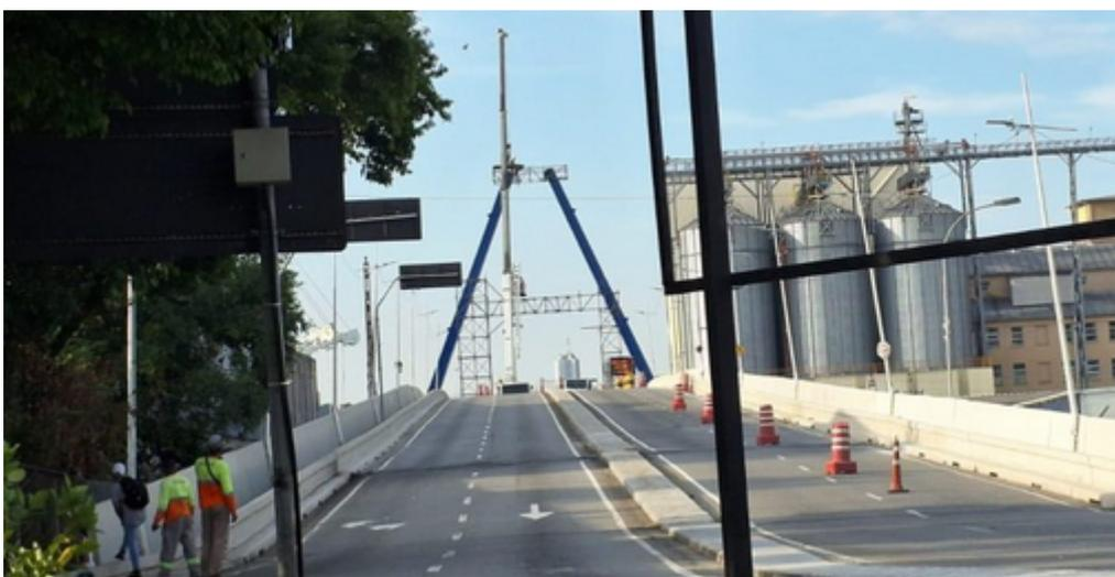
*Modernização contempla restauração arquitetônica, novos asfalto e iluminação de Led, instalação de cabos estaiados e novo sistema de drenagem*
