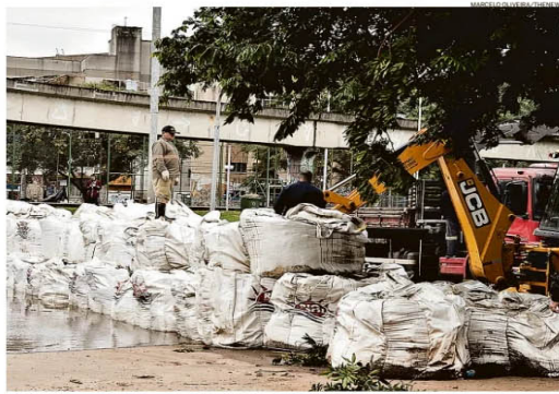
Medida de emergência. Sacos são usados para formar trincheira contra a alta do Rio Guaíba em Porto Alegre
