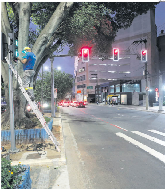
MAOS A OBRA. Funcionários da Newstec já iniciaram a substituição dos semáforos em trecho da Goiás, na região central
