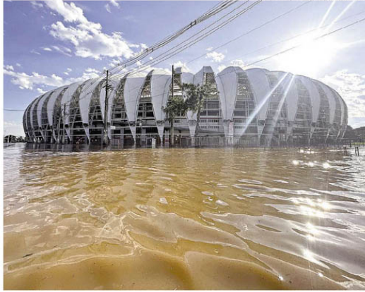
Estádio Beira-Rio parece boiar na enchente da capital: inundações paralisam comércio e serviços básicos
